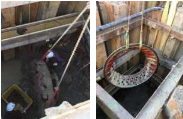
Demontage / Reinigung Schneidrad und Konus
